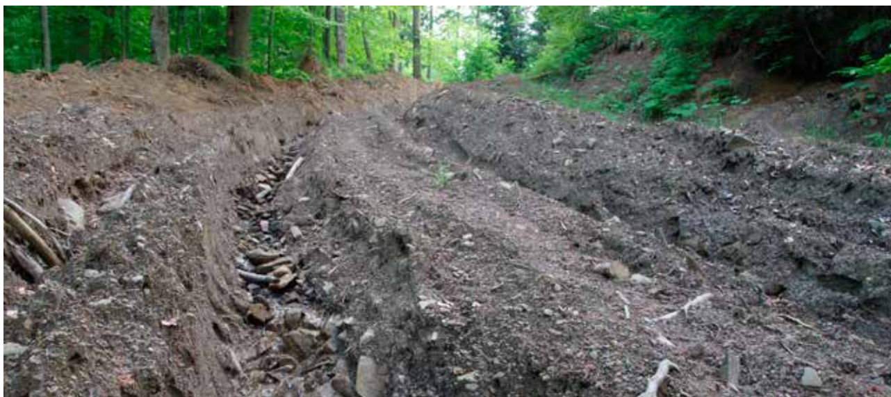
Fot. 8. Głęboka erozja drogi zrywkowej – las pod górą Obnoga; fot. Robert Kościelniak
